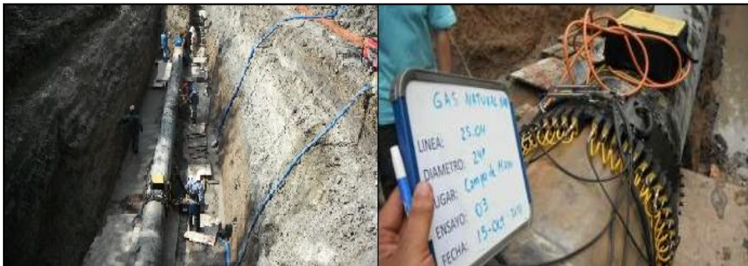
Figura 13. Izq: Excavación en línea 25.04. Der: Ondas Guiadas en ducto 25.04.
