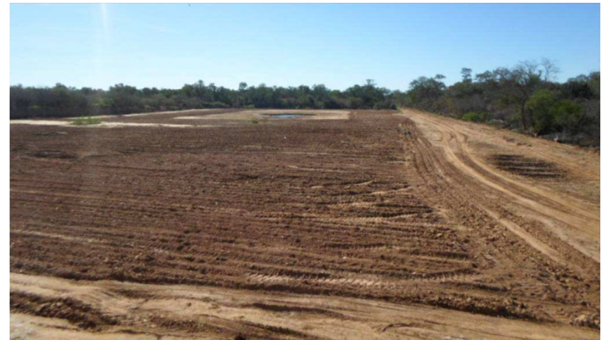
Zonas 1 y 2 Remediadas
