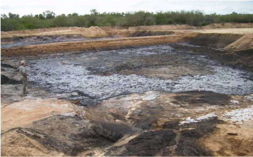
Mayo 2013 – Construcción taludes
