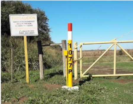
Son relevamientos normativos, que tienen por finalidad evaluar la eficiencia el sistema de protección catódica en estructuras enterradas (en Gtos. 1 punto de medición cada 1000mts aprox. en CT-1)
