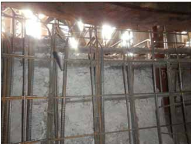
Figura 20. Fotografía desde interior de refuerzo de armaduras y malla.
