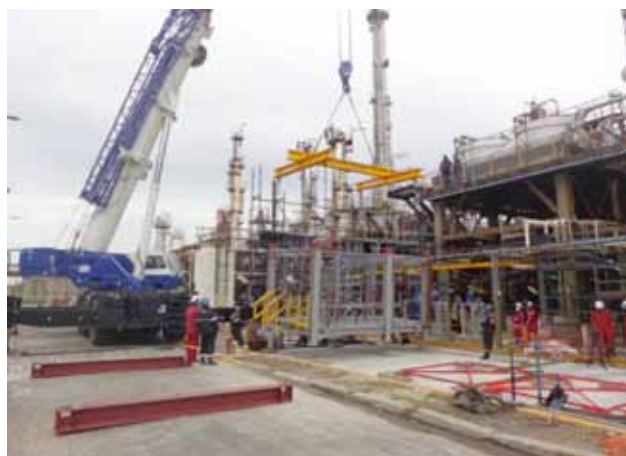
Figura 15. Montaje del primer módulo de la PFU.
