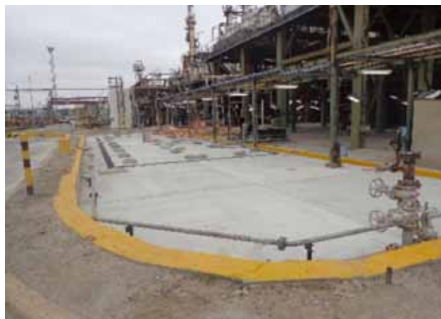
Figura 14. Construcción de nueva platea para la PFU.
