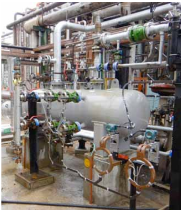
Figura 4. Evaporador de propano E-2101.
