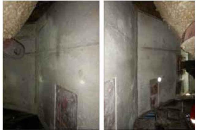
Figura 26. Fotografías interiores de trabajo terminado.
