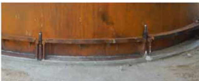
Figura 25. Fotografía de grouting y sellado finalizado.
