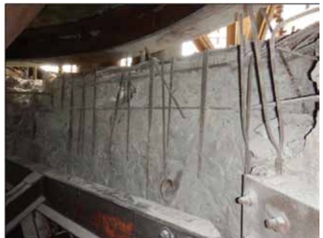
Figura 17. Demolición de hormigón en malas condiciones.
