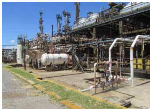
Figura 12. Desmontaje de antigua U-800.
