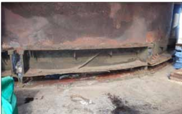
Figura 16. Fotografía de cámara elevada.
