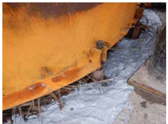
Figura 22. Fotografía de colocación de puente de adherencia.
