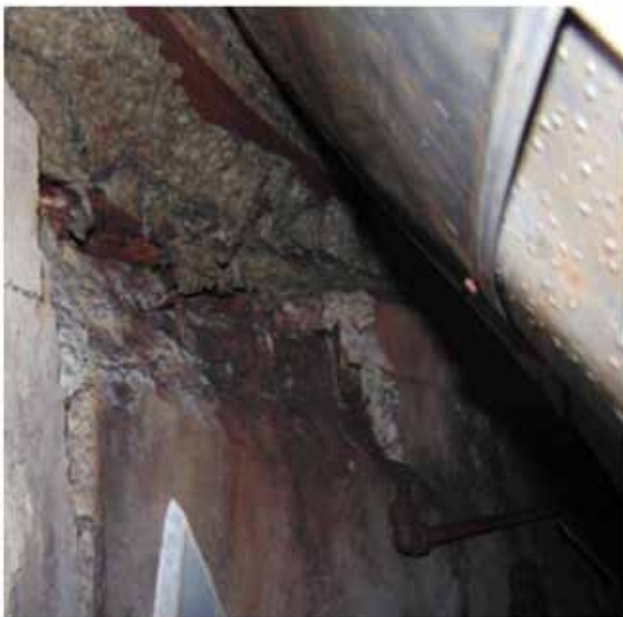
Figura 8. Pared interior de losa de soporte.
