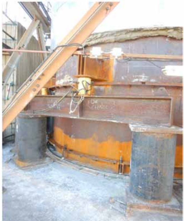
Figura 14. Fotografía de sistema de elevación.
