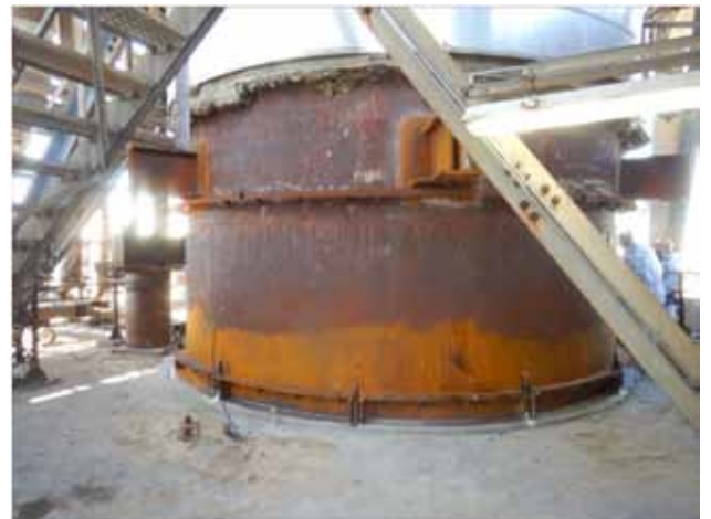
Figura 27. Fotografía exterior de trabajo terminado.
