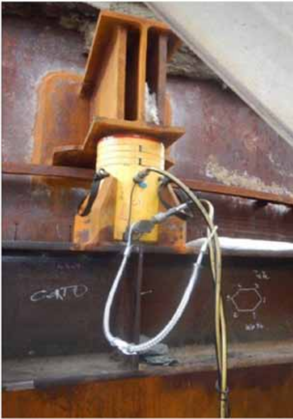
Figura 15. Fotografías de sistema de elevación y ménsulas de soporte en la estructura.
