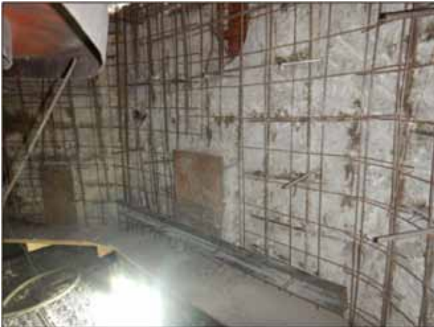
Figura 19. Fotografía desde interior de refuerzo de armaduras y malla.
