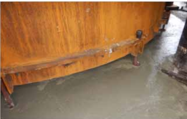
Figura 24. Fotografía de hormigonado terminado.
