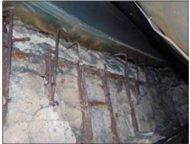
Figura 9. Pared interior de la losa de soporte.
