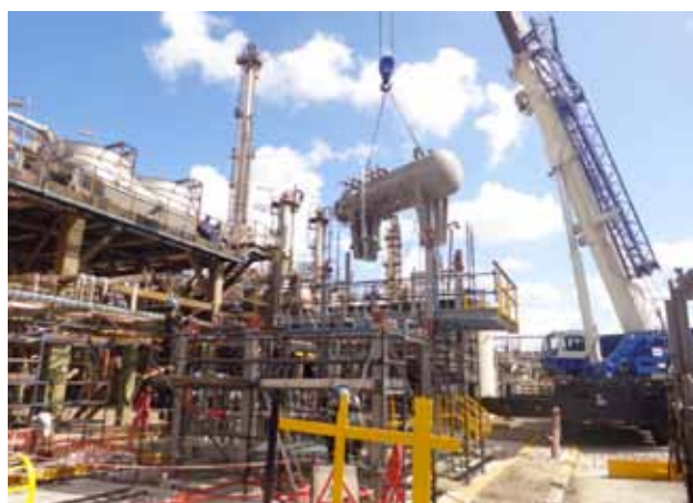
Figura 16. Montaje del recipiente acumulador de la PFU.
