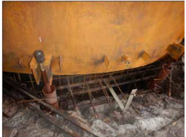
Figura 21. Fotografía desde exterior de refuerzo de armaduras y malla.
