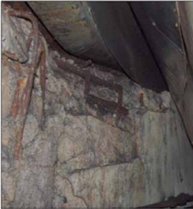
Figura 7. Pared interior de losa de soporte.
