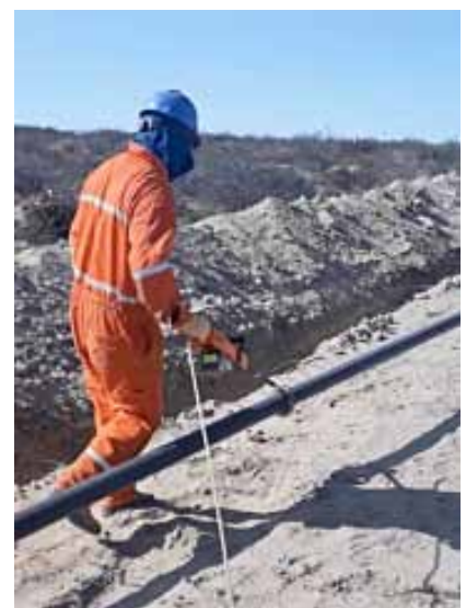
Figura 13. Pasaje de Holliday detector sobre el revestimiento externo.
