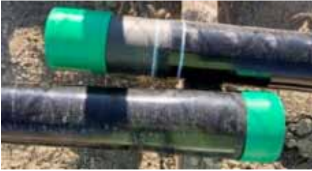
Figura 2. Tuberías revestidas externamente.
