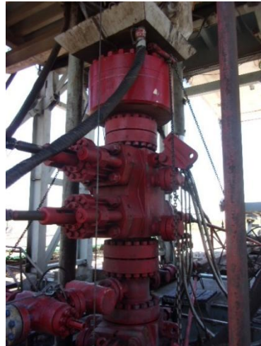
Imagen 5: Bandeja de contención sobre la BOP
