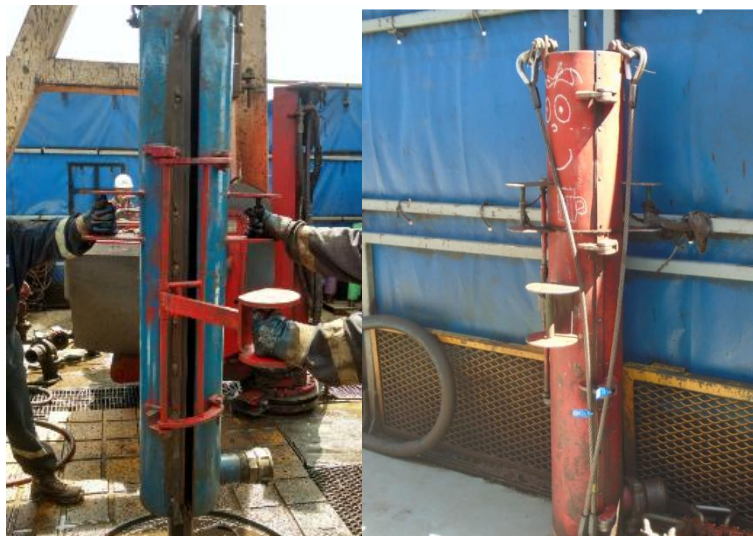
Imagen 2: Vista del economizador.
